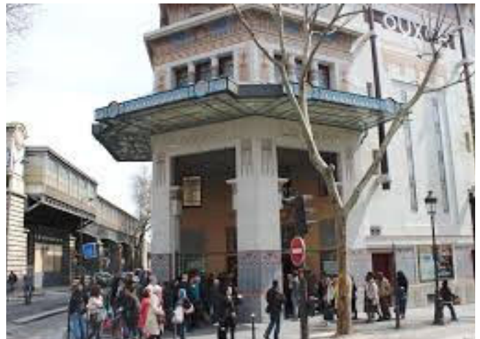
Paris, métro Barbès : le cinéma Luxor de style exotique égyptien. Fermé depuis 1987, le cinéma a rouvert ses portes le 17 avril 2013 avec trois salles. Une réhabilitation exemplaire.
